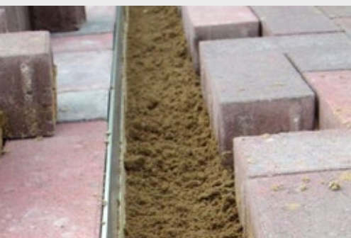
Grundprofil mit Alu-Sichtschiene Basic profile with aluminium section
